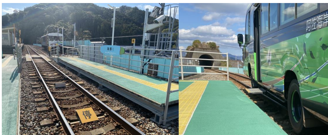
写真Ⅳ-7 DMV用に改築された穴喰駅のホーム 撮影：小野田（2024.1.29）
