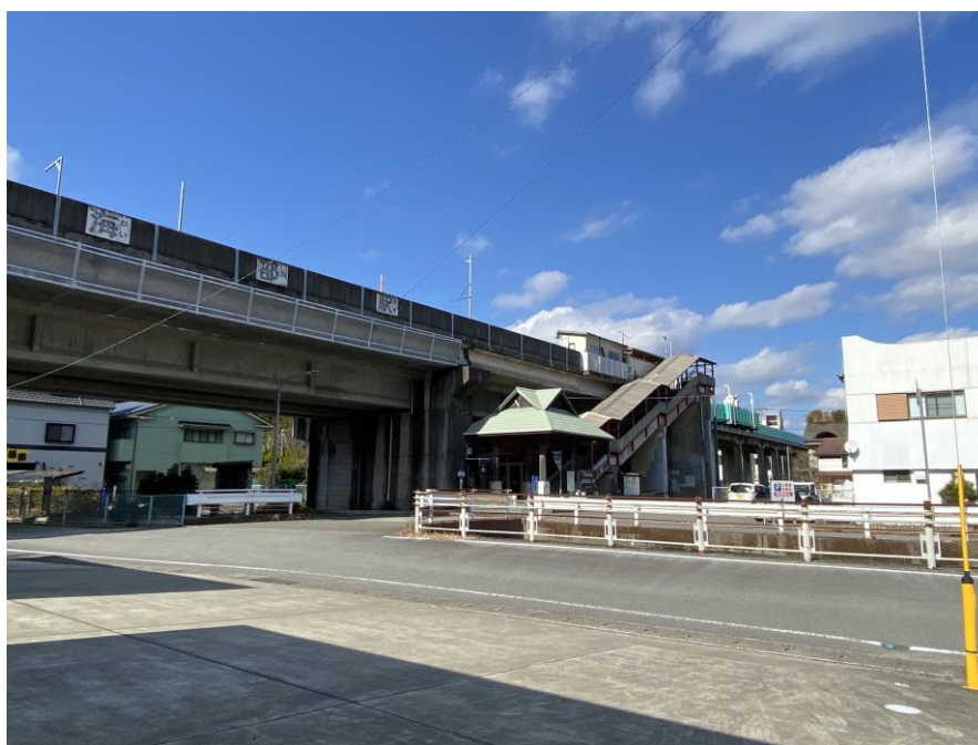
写真IV－10 市街地に設置された高架の海部駅
